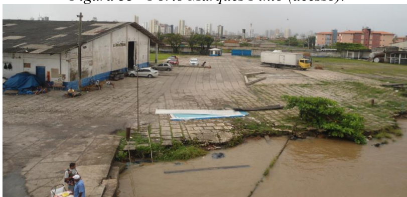
Figura 33 - Porto Marques Pinto (acesso).
