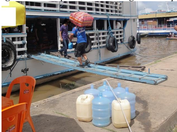
Figura 57 - Rampa de acesso sem guarda corpo.
