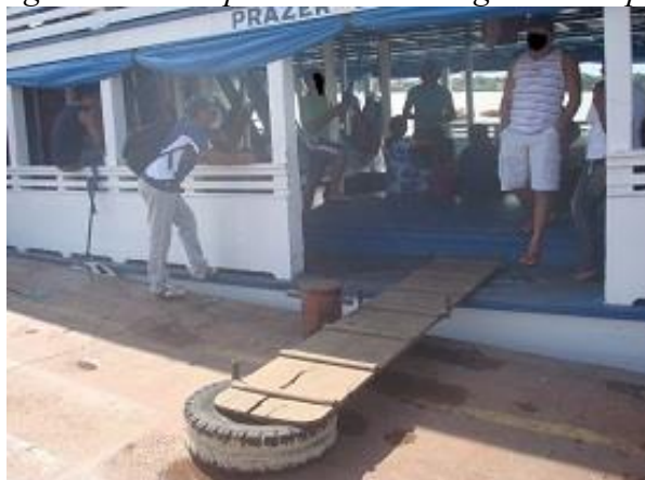
Figura 56 - Rampa de acesso sem guarda corpo.
